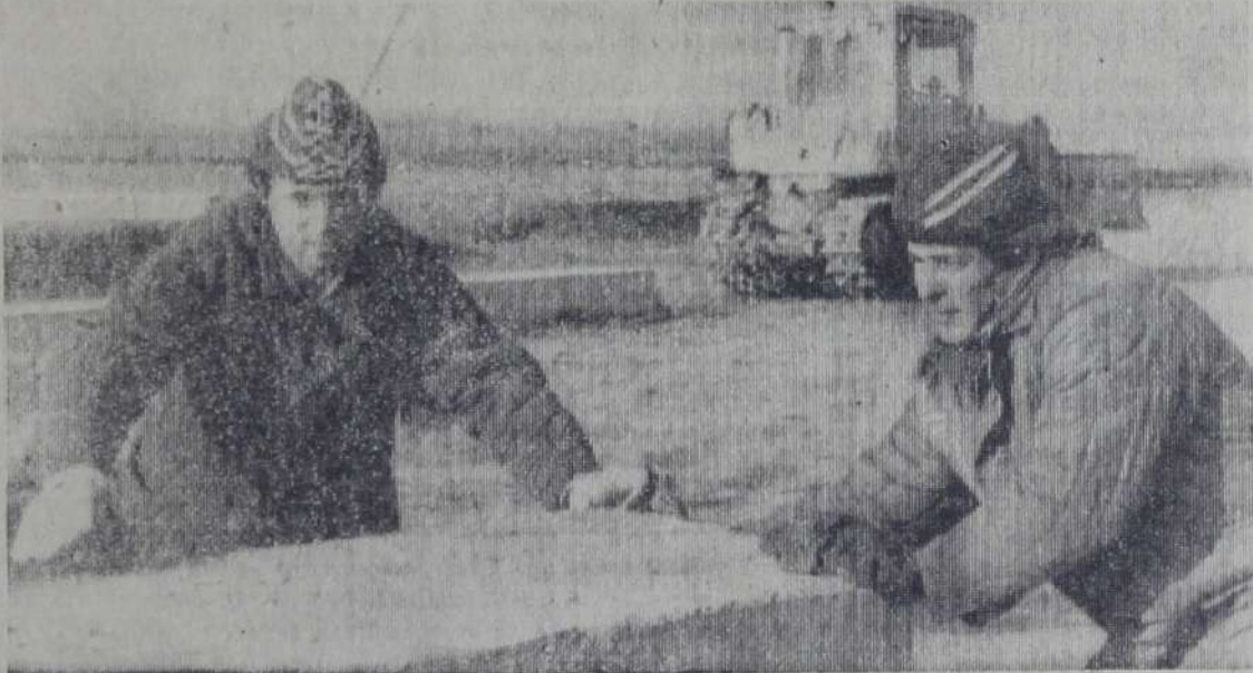
На строительстве объектов мелиорации успешно трудится коллектив бригады треста «Балазоводстрой», руководимой Ю. Н. Самариным. Сейчас монтажники ведут интенсивные работы по монтажу электрических подстанций, которые будут обеспечивать электроэнергией плучную насосную станцию «Поток».
