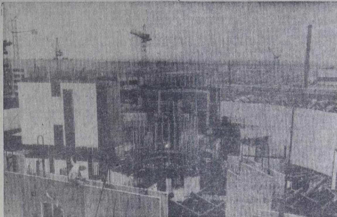
На строительстве первого реактора.
