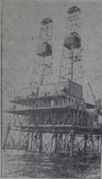
**Азербайджанская ССР. Монтаж самой большой на Каспийском море платформы для бурения скважин на стометровой глубине, ранее недоступной проходчикам, завершен на месторождении «28 Апреля», что в ста километрах от Баку.**
