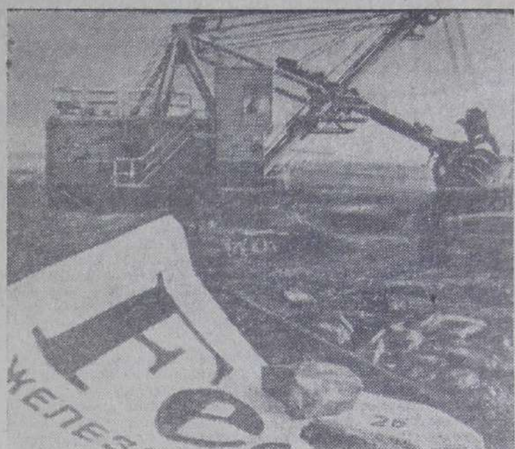
Белгородская область. Курская магнитная аномалия сегодня — это огромное предприятие и стройка одновременно, где формируется мощный территориально-производственный комплекс.
