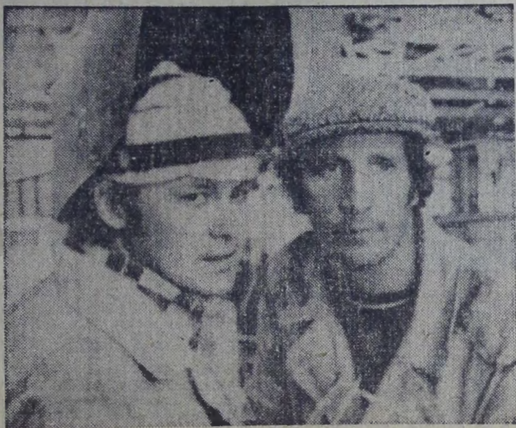
На сооружении насосной и компрессорной станций завода тяжелых землеройных машин с опережением графика трудятся электросварщик Г. И. Портнов и монтажник Н. П. Смирнов из бригады Н. А. Шугурова.
