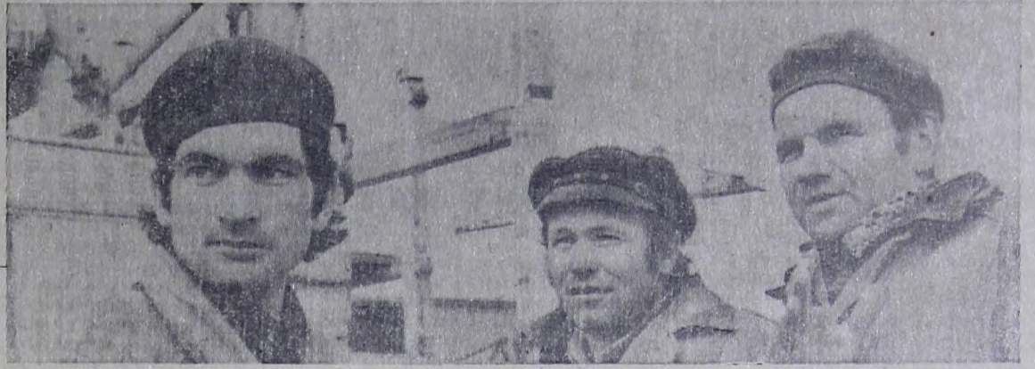
На строительстве корпуса № 60 завода-спутника КамАЗа высоких трудовых показателей добился коллектив бригады Е. Муругова, взявший социалистическое обязательство завершить монтажные работы к 60-летию ВЛКСМ.
