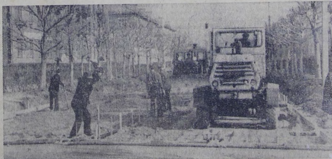
Бригады М. Г. Бондаря и В. А. Пономарева из четвертого участка УДСР славно потрудились в субботу на устройстве дороги на ул. Ленина. Уложено 100 кубометров бетона на площади 500 квадратных метров.
