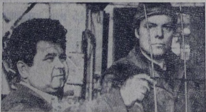
По-ударному трудится бригада электросварщиков домостроительного комбината на изготовлении армокаркасов для плит перекрытия. Коллектив выпускает 8 армокаркасов вместо шести по норме. На снимке: бригадир Ю. И. Зенков (слева) и В. А. Васильев. Фото М. Бабенко.
