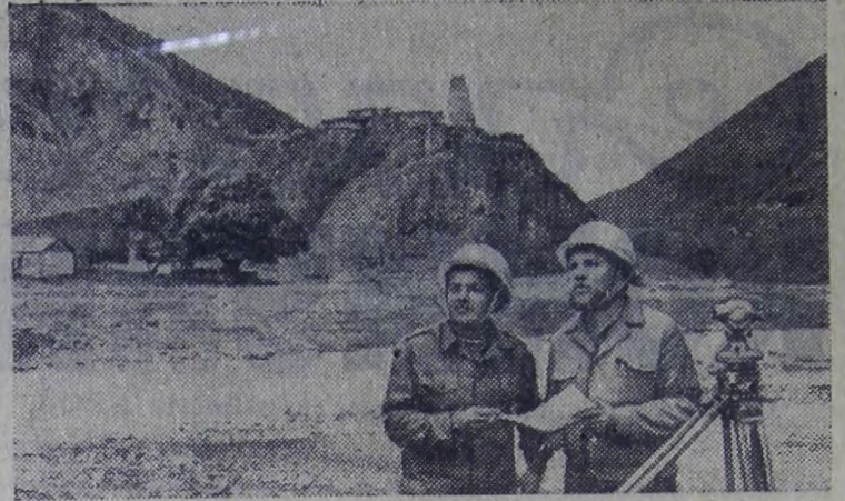
прораб мостоотряда № 40 Н Грищенко на строительстве.
