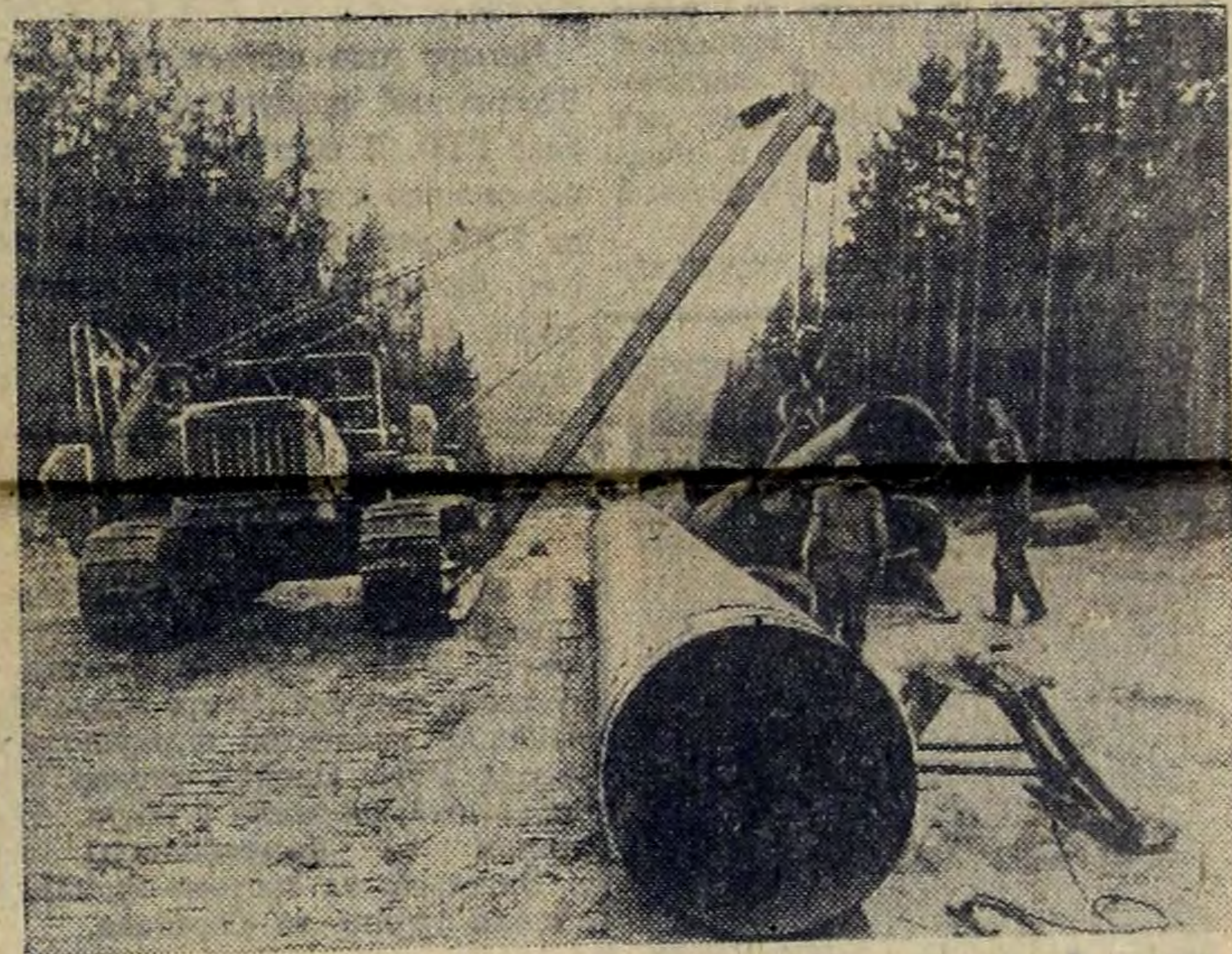
Чехословацкие строители завершают прокладку второй ветви транзитного газопровода СССР — Западной Европа. Сооружение трассы протяженностью в 400 километров объявлено одной из важнейших строк нынешнего года — первого года шестой чехословацкой пятилетки. Когда этот отрезок вступит в эксплуатацию, пропускная способность всей газовой магистрали возрастет почти в три раза.
