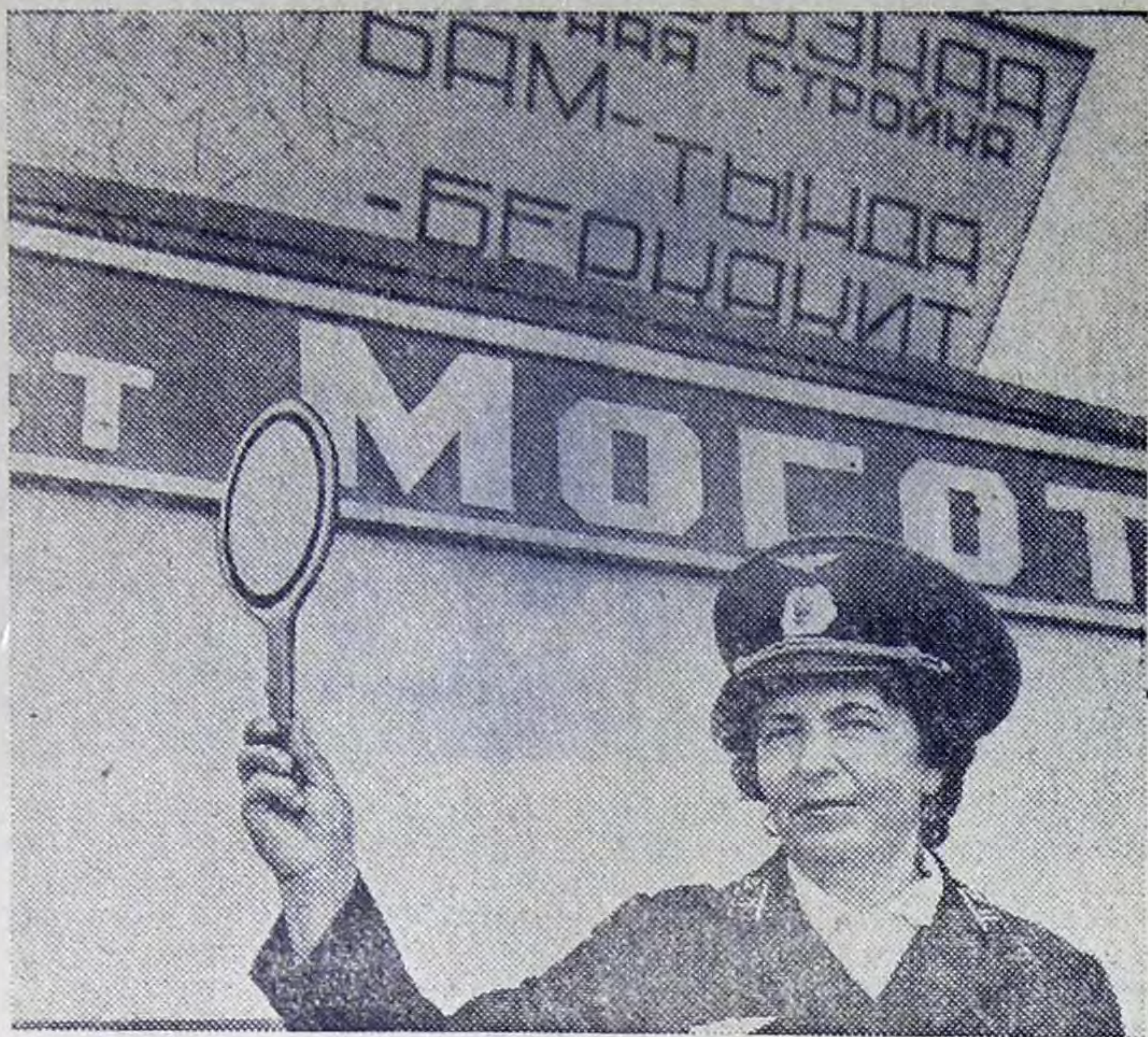
Амурская область. В таежный поселок Могот, на будущую крупную станцию линии Тынды-Беркамит, пришел первый поезд. Строители отсыпали в полотно железной дороги более 3 миллионов кубометров грунта, возвели 37 мостов, уложили 19 водоотводных труб.
