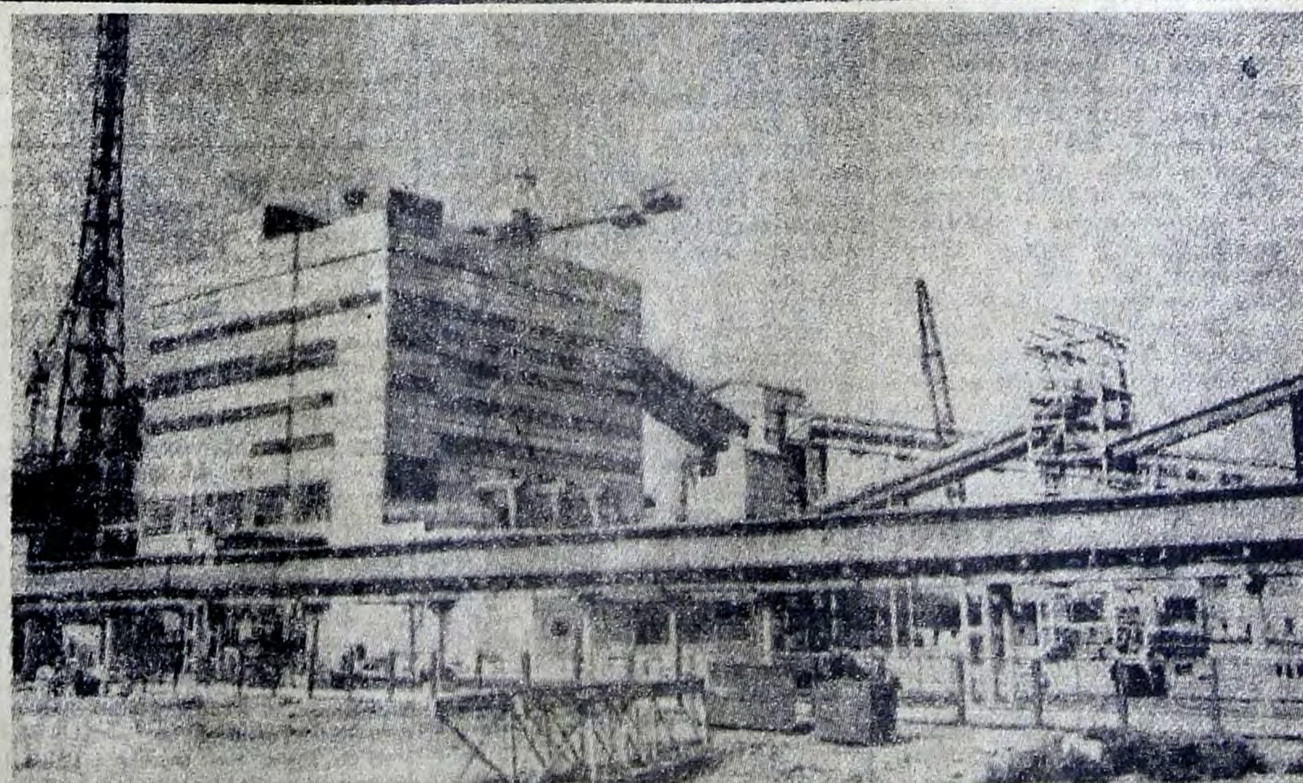
На снимке: химический завод. Строительство третьей очереди сернокислотного производства.
