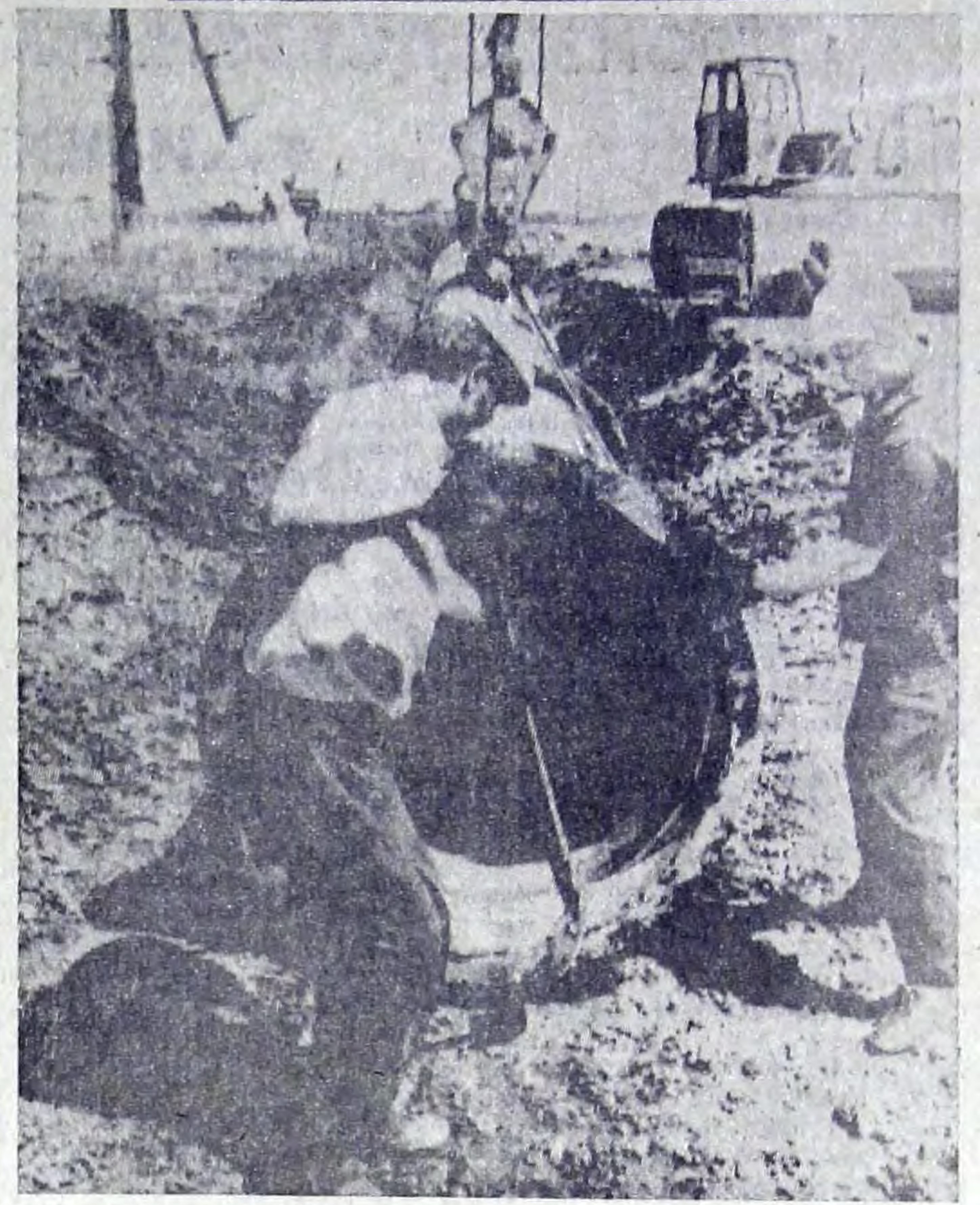
В совхозе «Волгарь» готовится под орошение еще одно поле в 212 гектаров, на котором предполагается выращивать овощи. На снимке: члены бригады В. Верейкина из ПМК-61 за укладкой водовода на новом поле.
