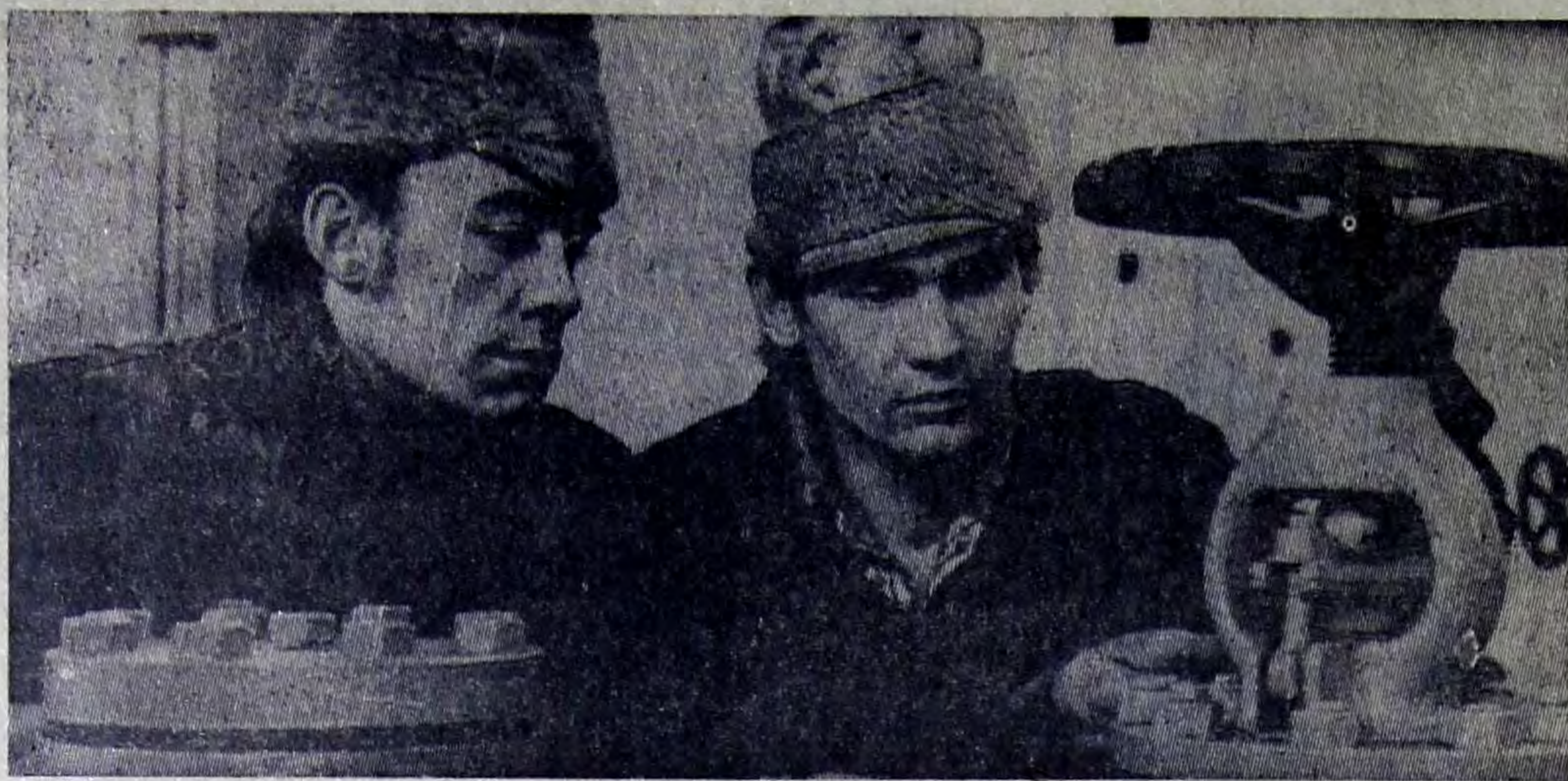
Слаженно и со знанием дела производят ремонт механической части гидротурбин на Саратовской ГЭС им. Ленинского комсомола слесари ударники коммунистического труда Валерий Буров и Геннадий Бойчук. Уделяя особое внимание качеству производимых работ, они с опережением графика завершают ремонтные работы. Оба акти-
