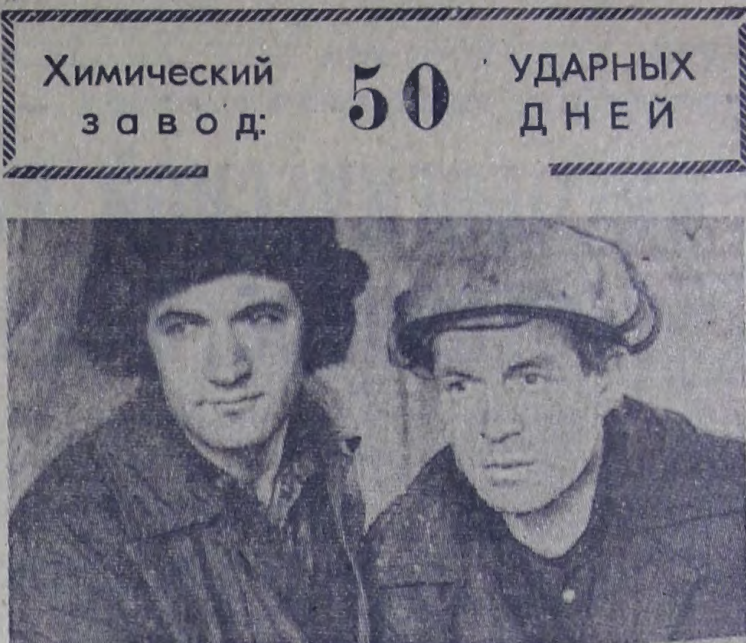
Успешно реализует повышенные обязательства, взятые в честь XXV съезда партии, коллектив бригады В. Н. Рожкова, производящий химзащитные работы на второй очереди химзавода. В цехе упарки досрочно были сданы полы, аппарат первой позиции, три газохода.
