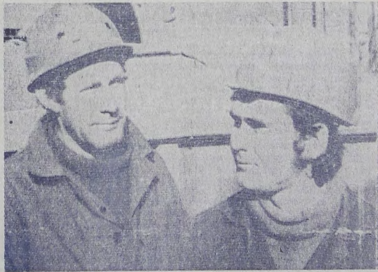
Монтажники БМУС П. Ф. Нифонтов и Г. Б. Неронов встречают XXV съезд партии новыми трудовыми успехами. На монтаже оборудования теплообменника химзавода они в полтора раза перекрывают нормы.
