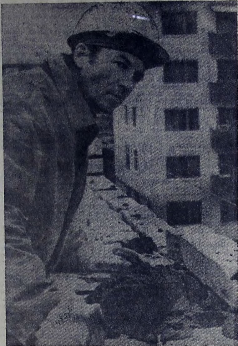
Высокими темпами ведет строительство жилья бригада В Сазамова треста «Промжилстройремонт».
