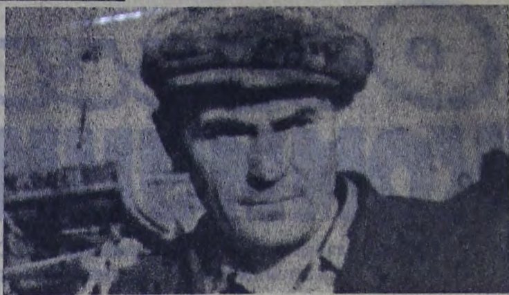
На днях состоялась торжественная закладка нового промышленного предприятия — завода самоходных землеройных машин. Первые кубометры бетона было поручено доставить на строительную площадку одному из лучших водителей АТК-1 В. Н. Закутнову.
