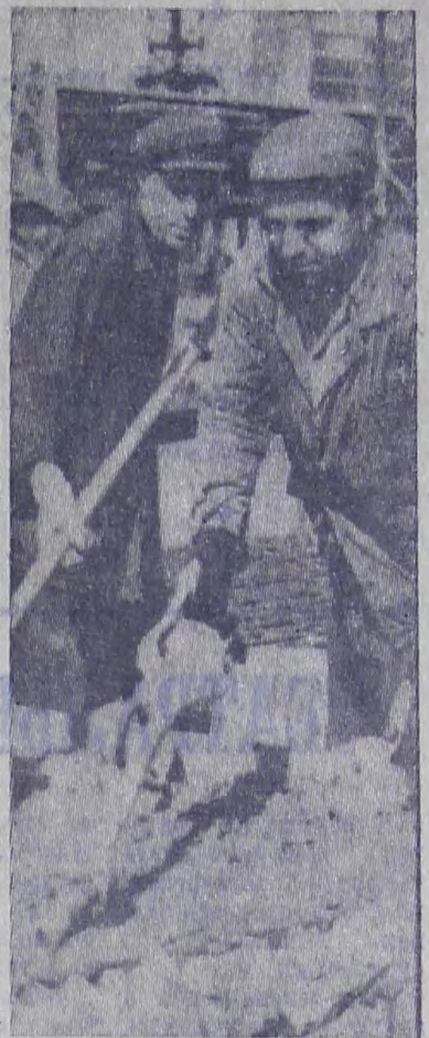
Бригада бетонщиков Н. Корнилова из СУ-1 на закладке фундаментов под склад готовой продукции химического завода систематически выполняет нормы на 130 процентов.
