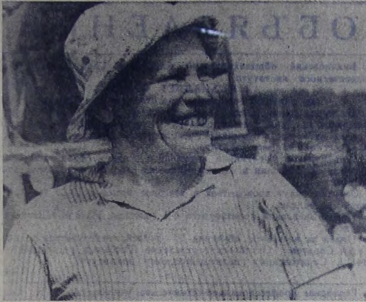
Строительство дороги Балаково—Вольск — еще один трудовой экзамен для коммуниста Е. П. Ингликовой. По отзывам товарищей по бригаде, Екатерина Павловна, работая на укладке асфальта, успешно справляется с этим экзаменом.
