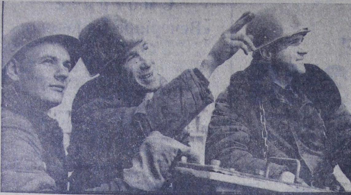
— Сдадим объект досрочно — ко Дню строителя с отличным качеством, — такое обязательство взяли члены бригады Петра Осипова из Балаковского специализированного монтажно-управления. И слово держат твердо. На сборке технологического оборудования сухой очистки газа для второго комплекса химзавода бригада добивается высокой производительности труда. НА СНИМКЕ: (слева направо) передовые монтажники А. Ковалев, Г. Миронов и Н. Ермолаев. Фото И. СИДОРЕНКО.
