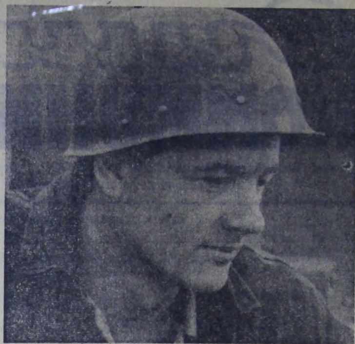
В бригаде Петра Осипова, что ведет монтаж печного отделения второй очереди химического завода, с высокими показателями трудится монтажник комсомолец Александр Ковалев. Приобрел к профессии монтажника Александр в 1968 году. Химзавод — его вторая ударная стройка.
