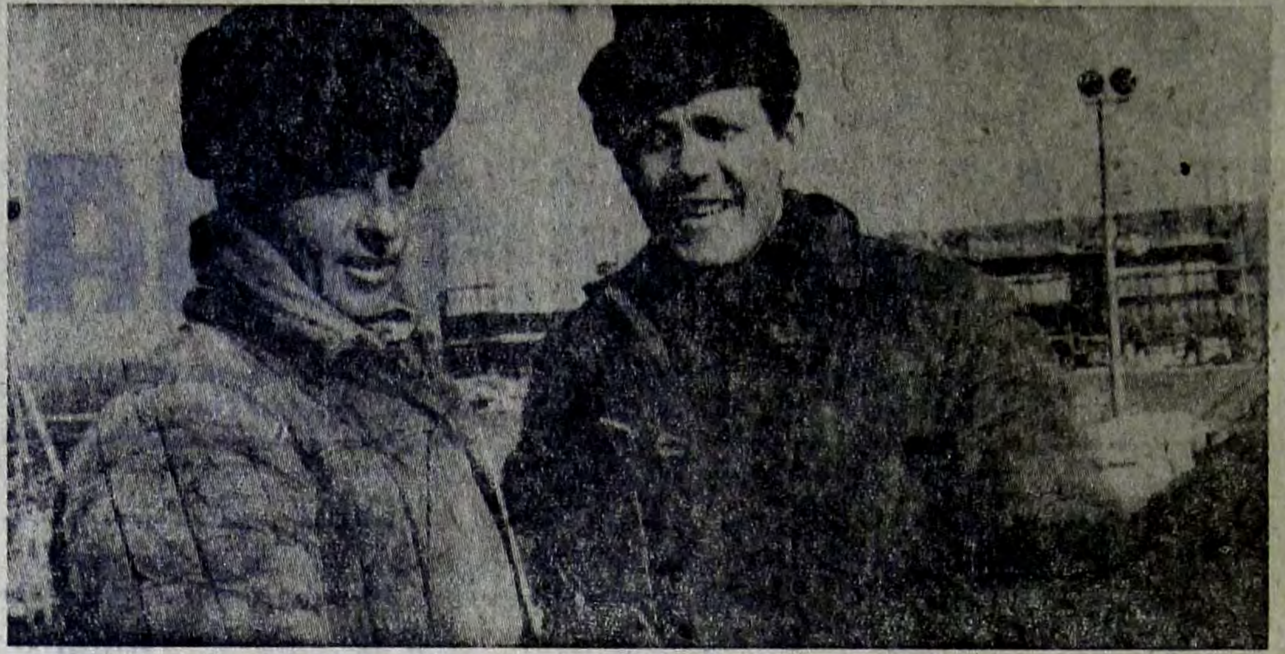
На сооружении пожарного депо завода фосфорных удобрений замечательными трудовыми показателями славятся каменщики из бригады В. Хорошилова А. Юдин (слева) и коммунист
