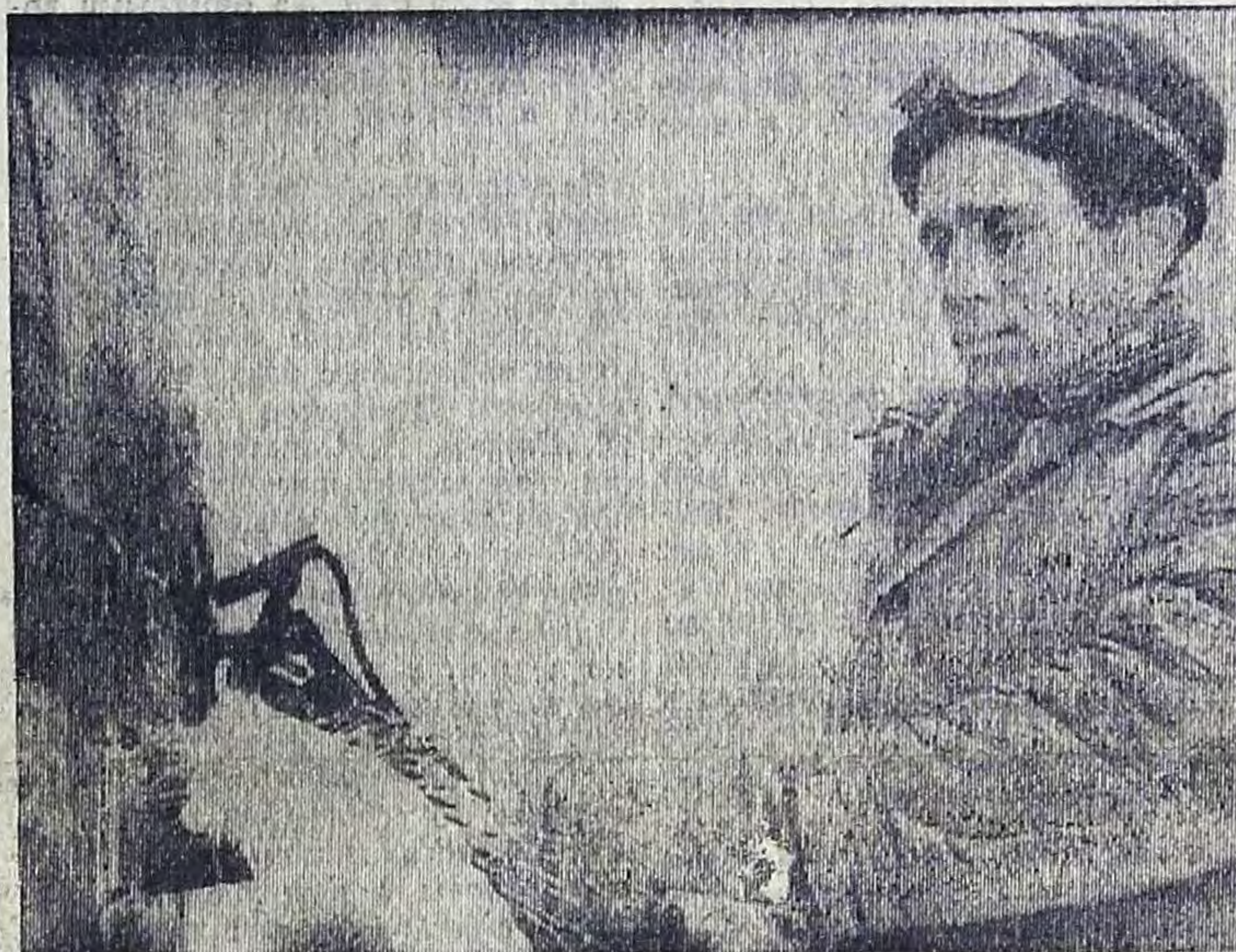
Геннадий Алексеевич Петрунин — разрезчик. На строительстве завода фосфорных удобрений комсомолец Петрунин работает с высокой производительностью. Сейчас он вместе с товарищами по бригаде, возглавляемой В. Саенко, занят сборкой нестандартного оборудования. В бригаде почти каждый имеет по несколько специальностей. Вот и Петрунин владеет еще и специальностью слесаря-монтажника. Фото Б. ВОРОНКИНА.
