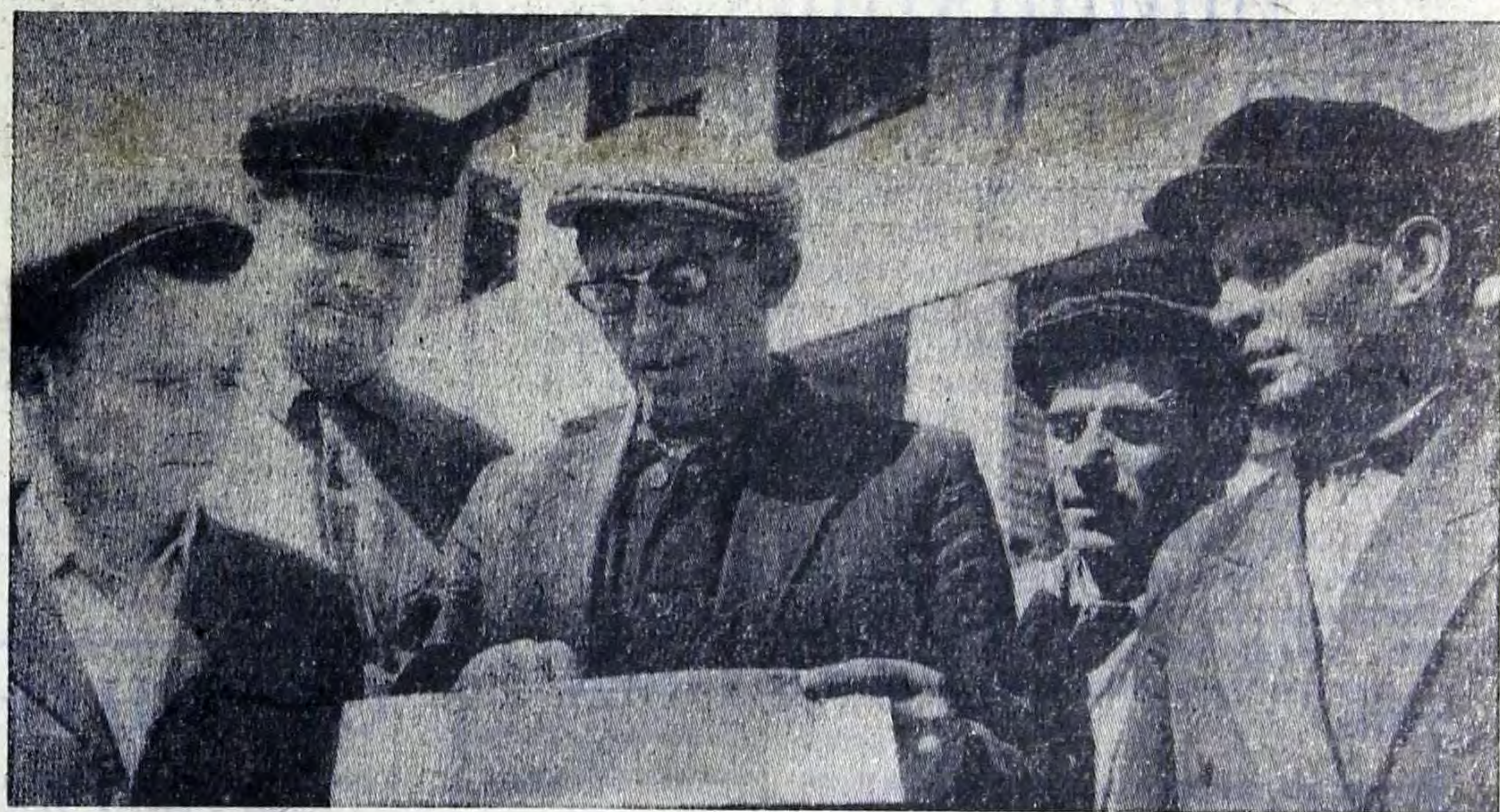
Растут производственные корпуса завода резиновых технических изделий. На их возведении трудятся многочисленные подразделения «Химстроя». Высокой выработки добиваются плотники-бетонщики из СУ-2. Здесь успешно трудится бригада Александра Арсентьевича Ментова. Сейчас
