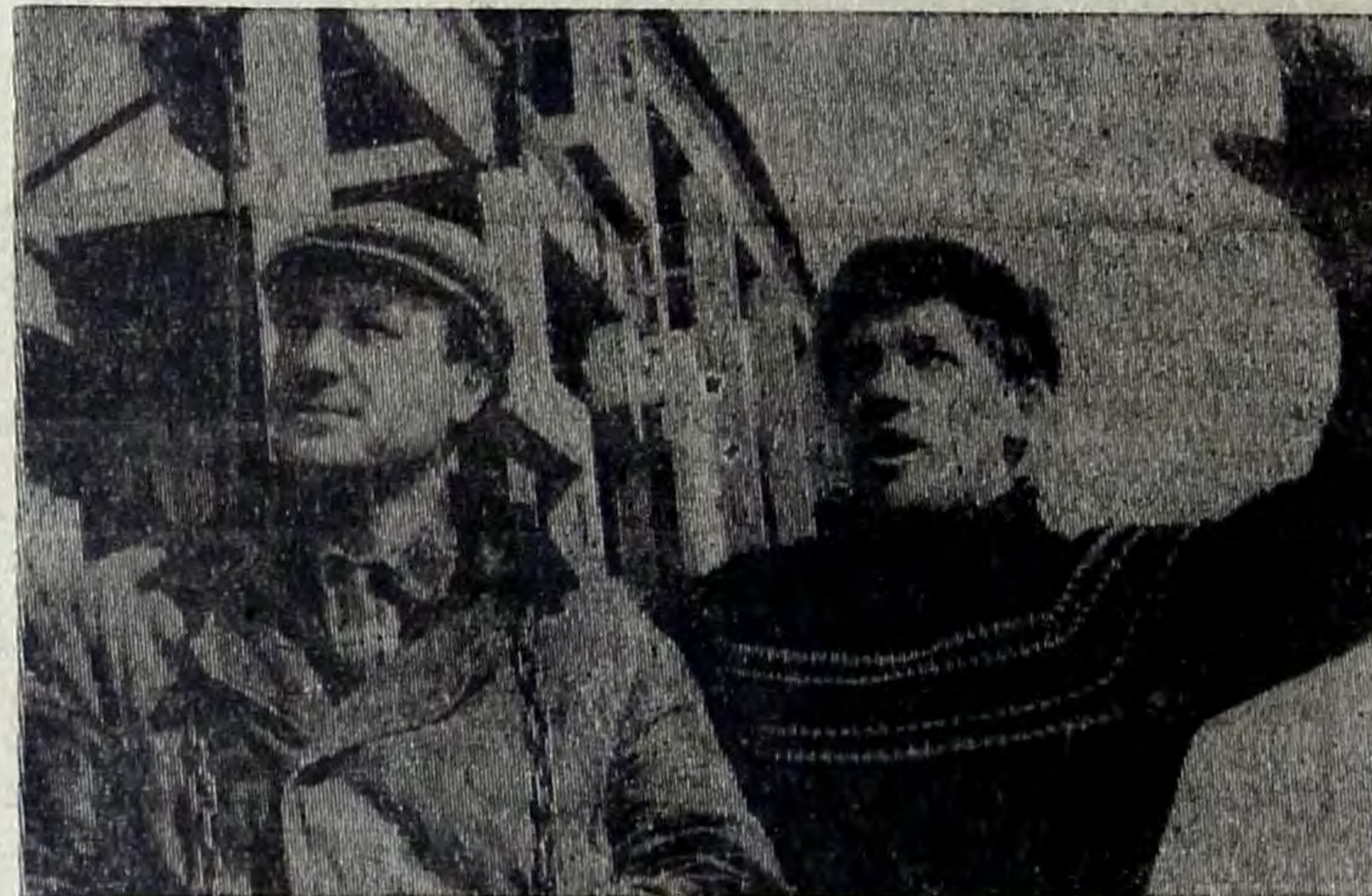
На строительстве судоремонтного завода высокопроизводительно трудятся монтажники Виктор Вельмисов и его молодой напарник Бронис Березнауск. Обладающий большим опытом Виктор Вельмисов многому научил Брониса. Сейчас они значительно перевыполняют сменные нормы выработки с хорошим качеством производимых работ. Фото М. БАБЕНКО.
