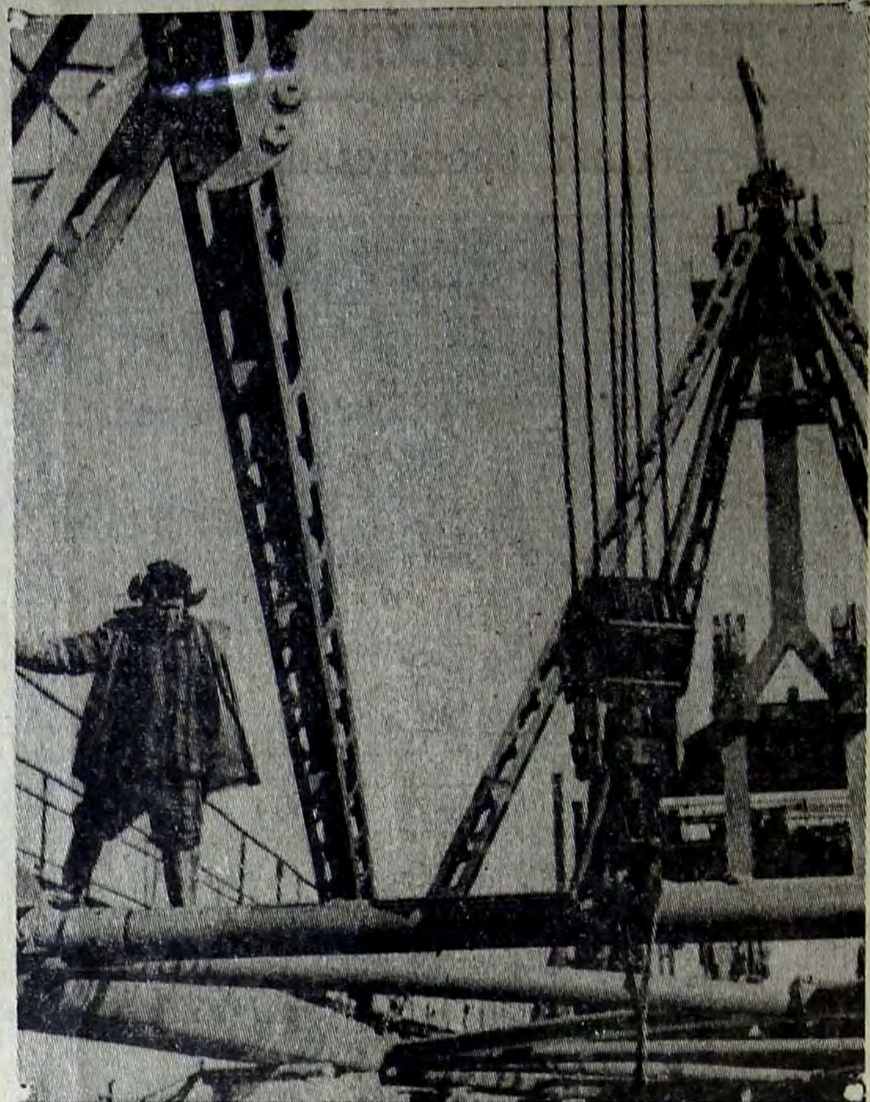
Саратовский оросительный канал. Скоро на прокладке голубой трассы плодородия начнет действовать шагающий экскаватор. НА СНИМКЕ: идет монтаж стрелы.
