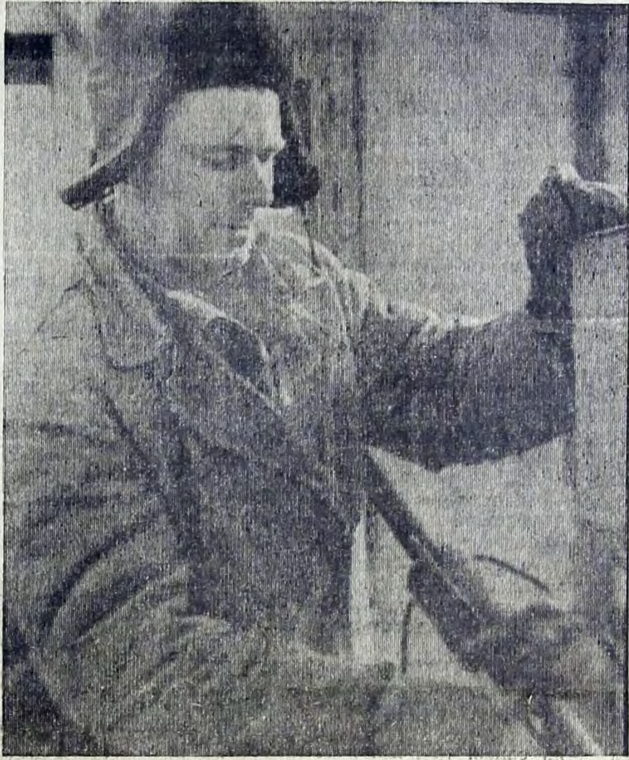
В управлении общестроительных работ отлично трудится звеньевой Николай Александрович Стебин. В коллективе он пользуется большим авторитетом. Сейчас ведет монтаж на очередном крупнопанельном доме № 64 по улице Трудовой. План выполняет на 130—140 процентов. Фото Б. ВОРОНКИНА.
