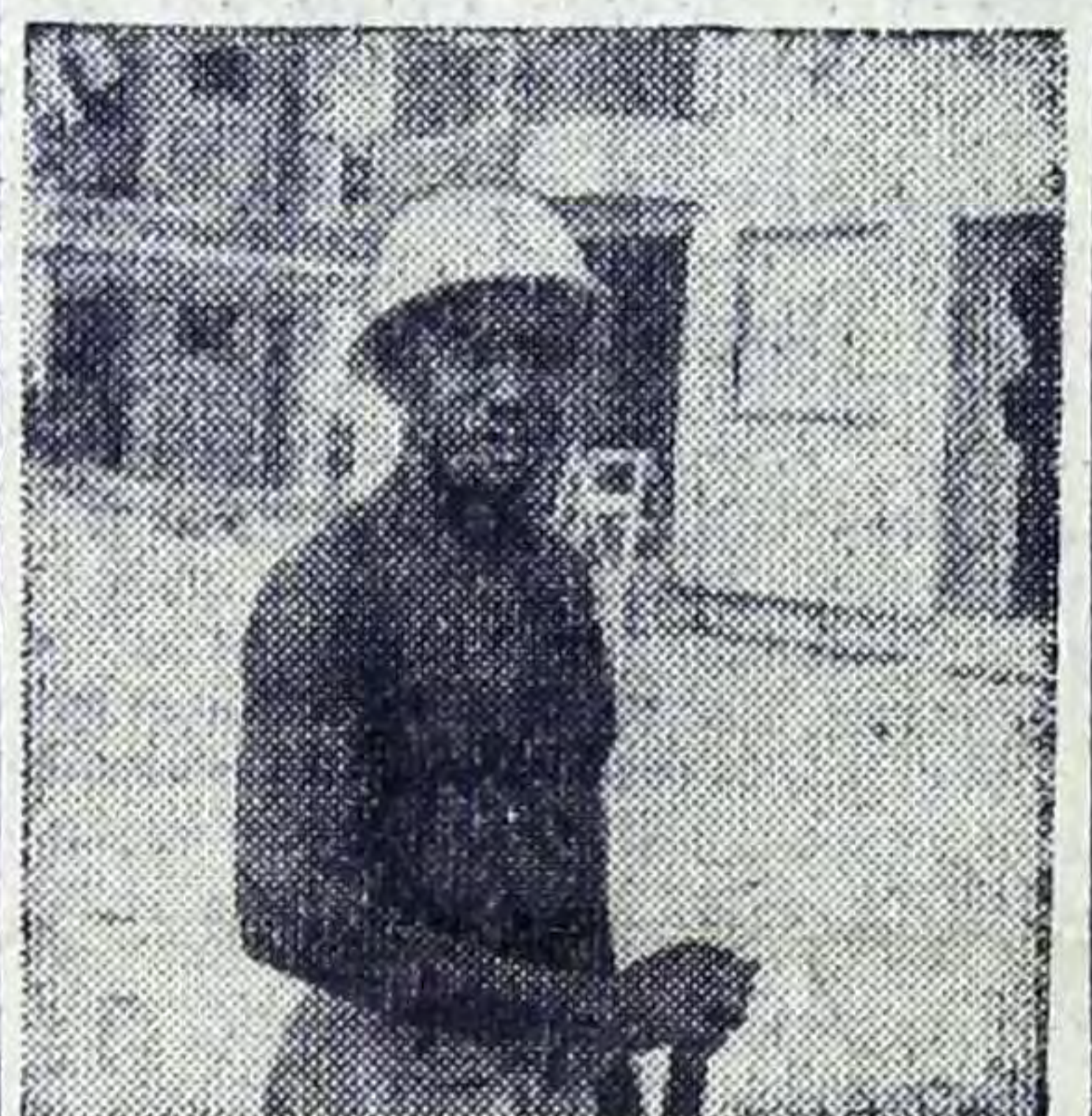
КУБА. В окрестностях Гаваны на берегу морского залива создается крупный жилой район — новостройка Аламар («К морю»). Здесь на стройке трудятся рабочие — добровольцы промышленных предприятий провинции Гавана. На снимке: строитель — доброволец Томас Портя — участник ударной стройки в Аламаре. Фото Е. Куницына. (Фотохроника ТАСС)
