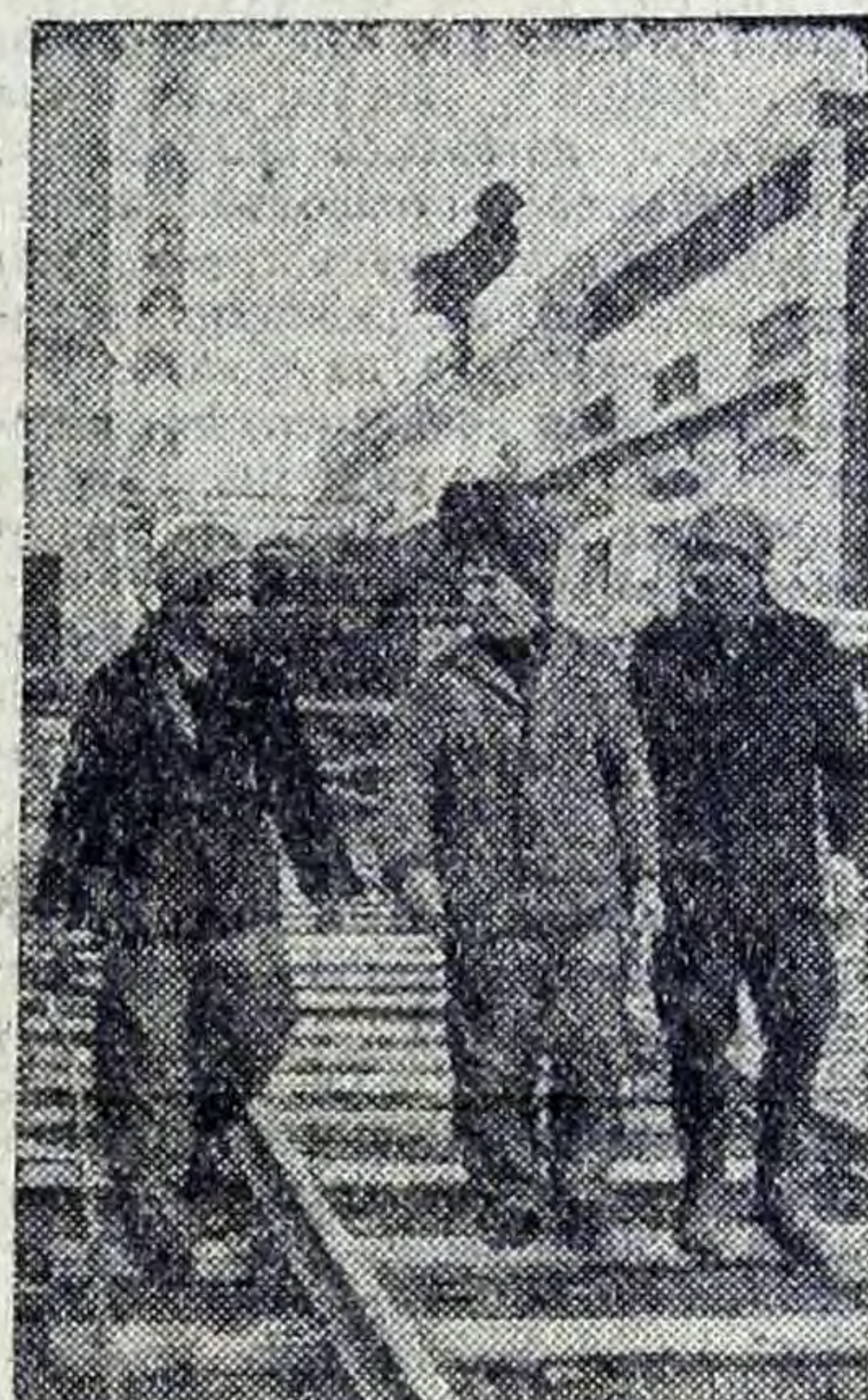
На окраине молодого литовского города Электрейнай взметнулись высоко в небо трубы Литовской ГРЭС имени В. И. Ленина. Сейчас на ГРЭС полным ходом идет монтаж последнего, восьмого энергоблока, мощностью 300 тысяч киловатт. По-ударному трудятся здесь рабочие многих национальностей страны. На ономике: строители станции ударники коммунистического труда (слева направо) литовец И. М. Каушас, русский Н. М. Корчагин и литовец С. И. Юрквичус.
