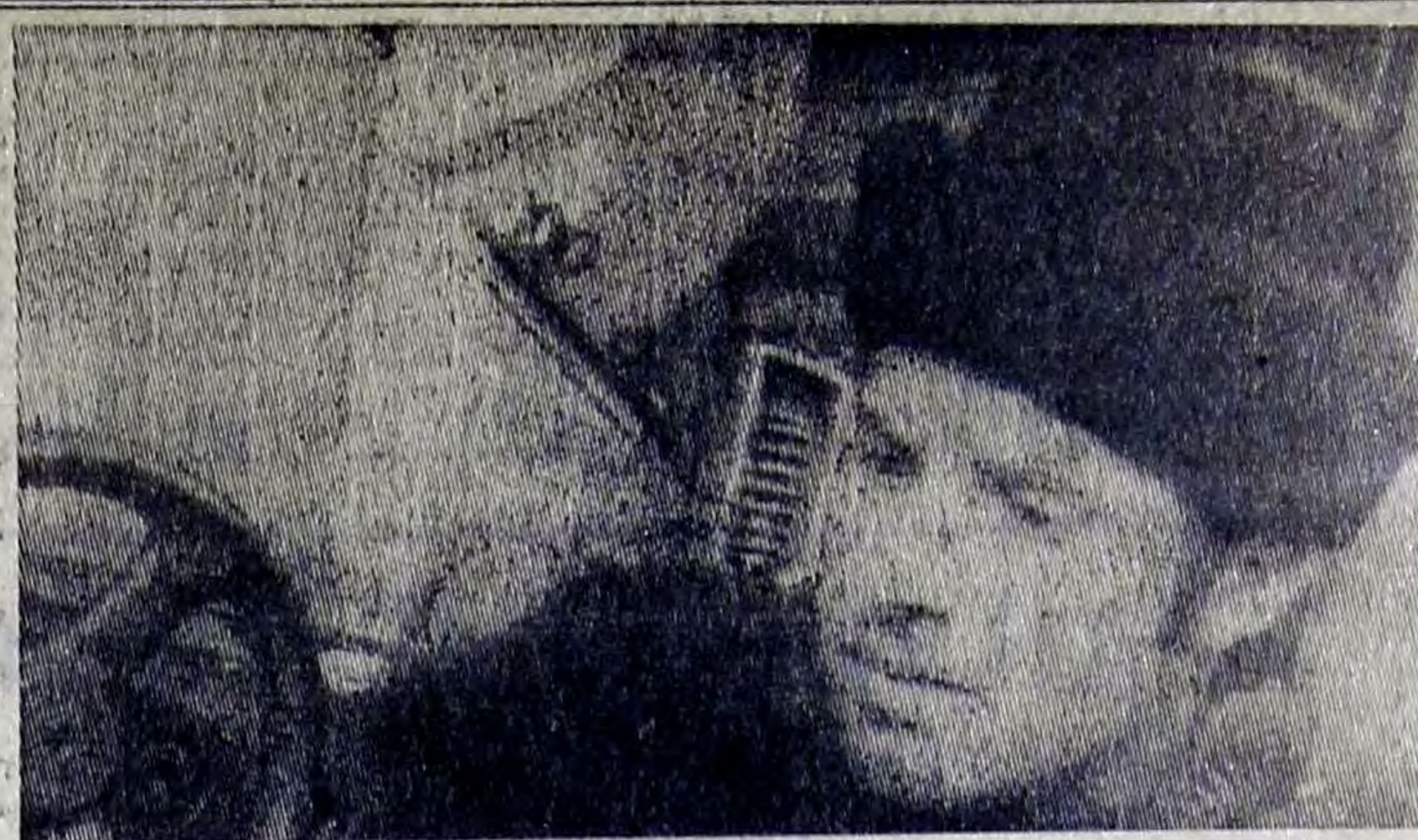
На снимке слесарь-монтажник Куйбышевского монтажного управления Валерий Баулин. Он вместе с товарищами по бригаде ведет сборку технологической линии по изготовлению битумных пластин в третьем производственном корпусе завода резинотехнических изделий.
