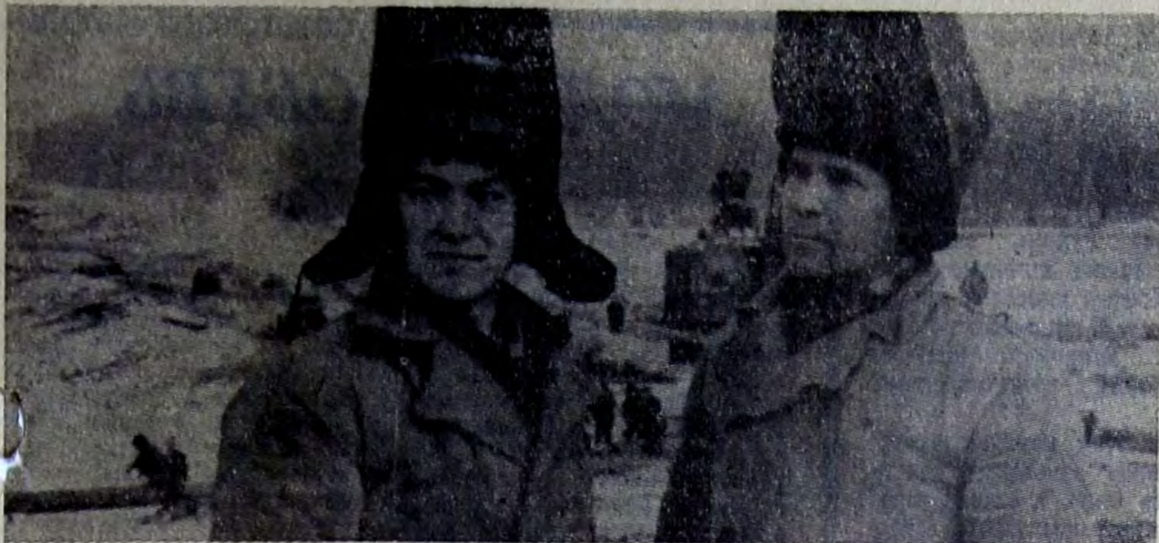
Высокими показателями в труде знаменуют каждую трудовую смену на сооружении плотины через реку Иртыш на строительстве Саратовского оросительного канала электросварщики из бригады А. Землянского Н. А. Дмитриев (слева) и А. П. Майоров. В сложных полевых условиях опытные строители выполняют сменные нормы до 140 процентов.
