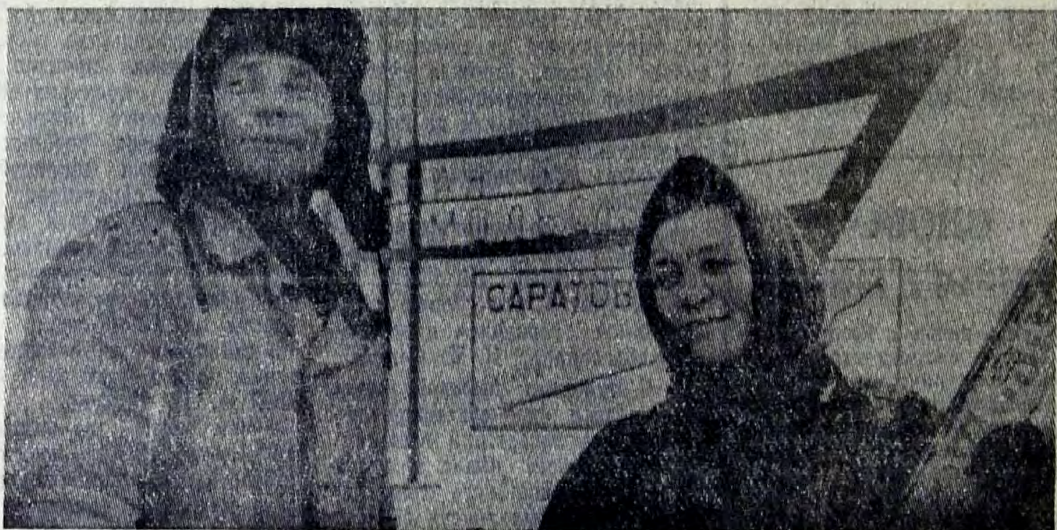
На головном участке водозабора Саратовского оросительного канала плотничные и бетонные работы успешно ведет бригада Ивана Николаевича Полякова. Перекрывая ежедневно сменные задания, коллектив бригады готовит достойную встречу предстоящему съезду КПСС.
