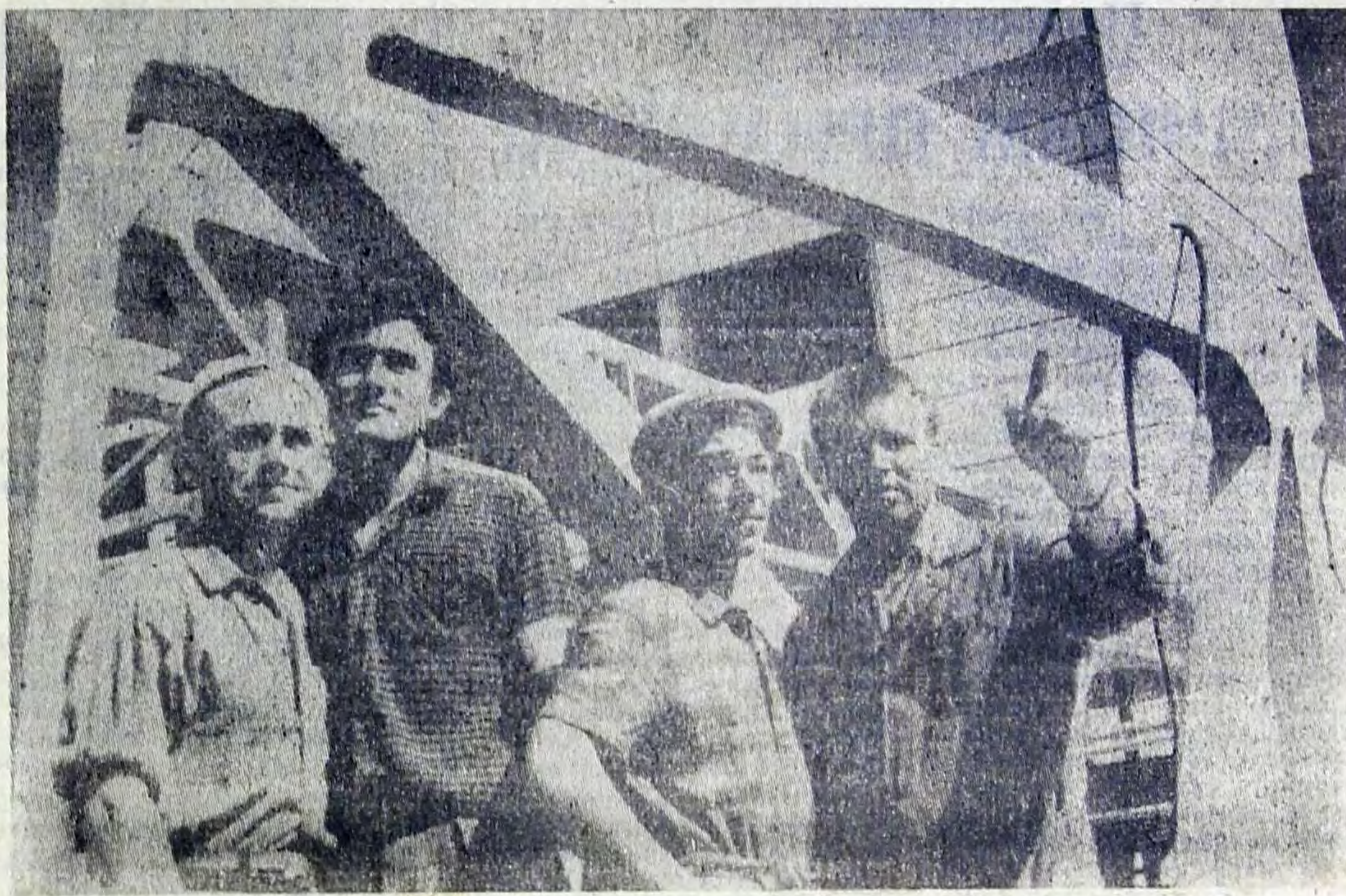
Комсомольско-молодежная бригада монтажников, возглавляемая Г. Максимовым, систематически перевыполняет плановые задания на монтаже ферм перекрытий главного производственного корпуса завода РТИ.
