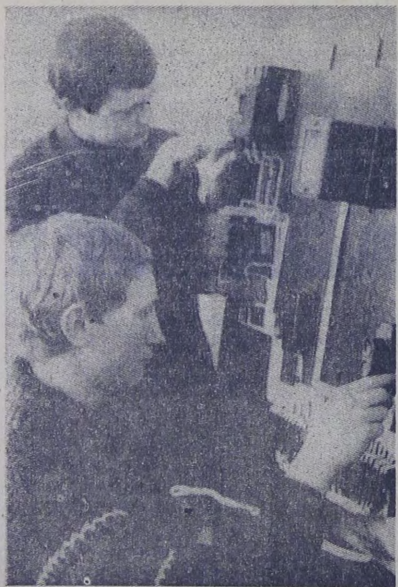
Учащиеся группы № 7 Виктор Злобин и Александр Сидоров ведут монтаж приборов электрического стенда в лаборатории. Фото В. Кирьянова.
