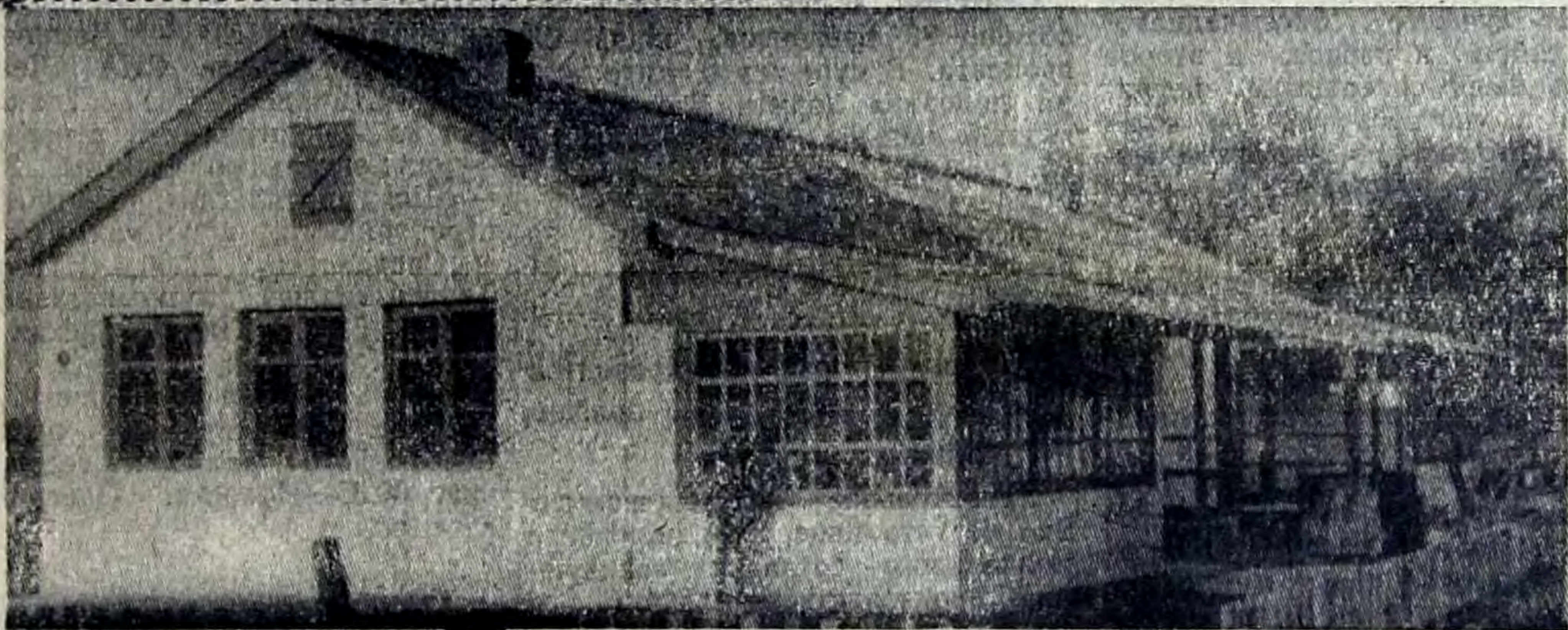
В последние годы широко развернулось строительство животноводческих ферм, домов культуры, жилых домов в колхозах и совхозах нашего района. НА СНИМКЕ: очередной дом, построенный в колхозе имени Чкалова.
