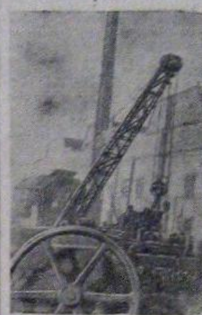
Выгрузка цехового оборудования на одном из восстанавливаемых заводов.
