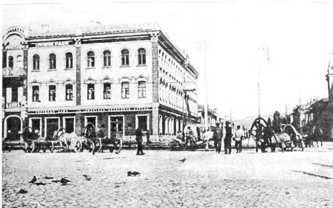
Здание торгового дома Борелей. Угол Царицынской и Александровской улиц
