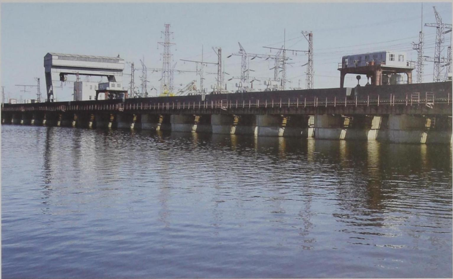
Гидроэлектростанция длиной 386 м, совмещенная с поверхностным водосливом, имеющим 24 пролета шириной по 12 м. Водосброс рассчитан на пропуск 16020 м<sup>3</sup>/с воды. Удельный расход на рисберме – 57 м<sup>3</sup>/с.
