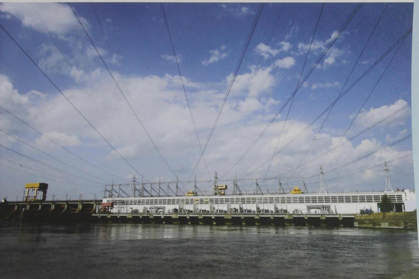
Водосбросная плотина длиной 191 м имеет 8 про-летов шириной по 20 м и рассчитана на пропуск 10960 м<sup>3</sup>/с воды. Удельный расход на рисберме – 58 м<sup>3</sup>/с. Особенностью плотины является пустотелая конструкция водослива, в пределах которой фунда-ментная плита заменена тонкой анкерной плитой, пригруженной грунтом.
