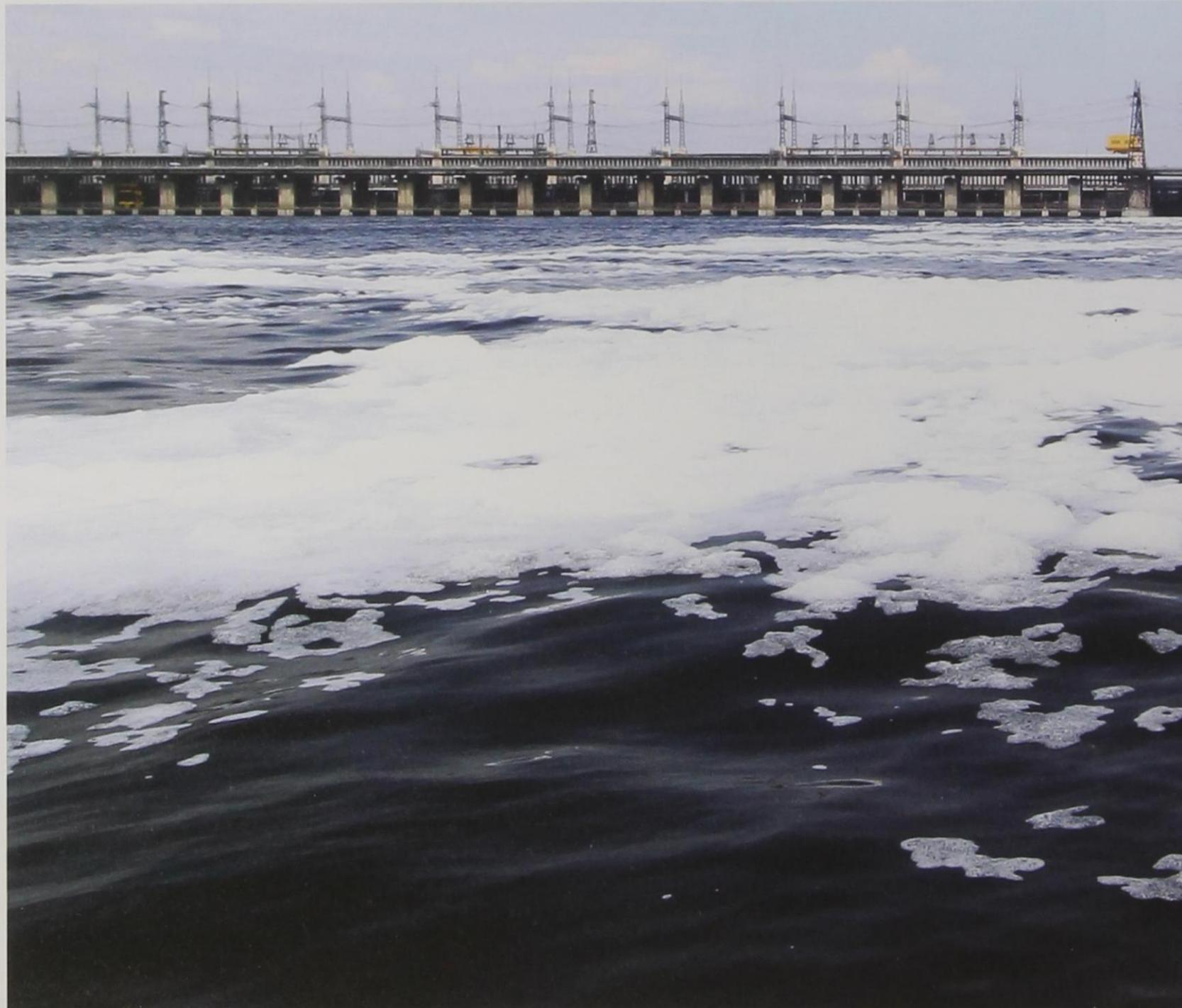
Сороудерживающие решетки вынесены из здания ГЭС и установлены в отдельном сооружении. Это позволило снизить потери напора за счет уменьшения скорости течения воды, а также исключить необходимость остановки турбин для очистки решеток.
