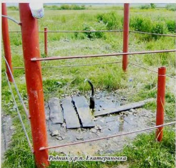
Родник нисходящего типа, с дебитом 0,3 м<sup>3</sup>/час расположен в 3 км от р.п. Екатериновка. Источник имеет ограждение. Однако из-за отсутствия обустроенного дренажа территория вокруг водозаборного устройства залита водой. Родник широко используется местным населением для питьевых нужд. Ежедневное количество потребителей в среднем составляет 80-100 человек.
