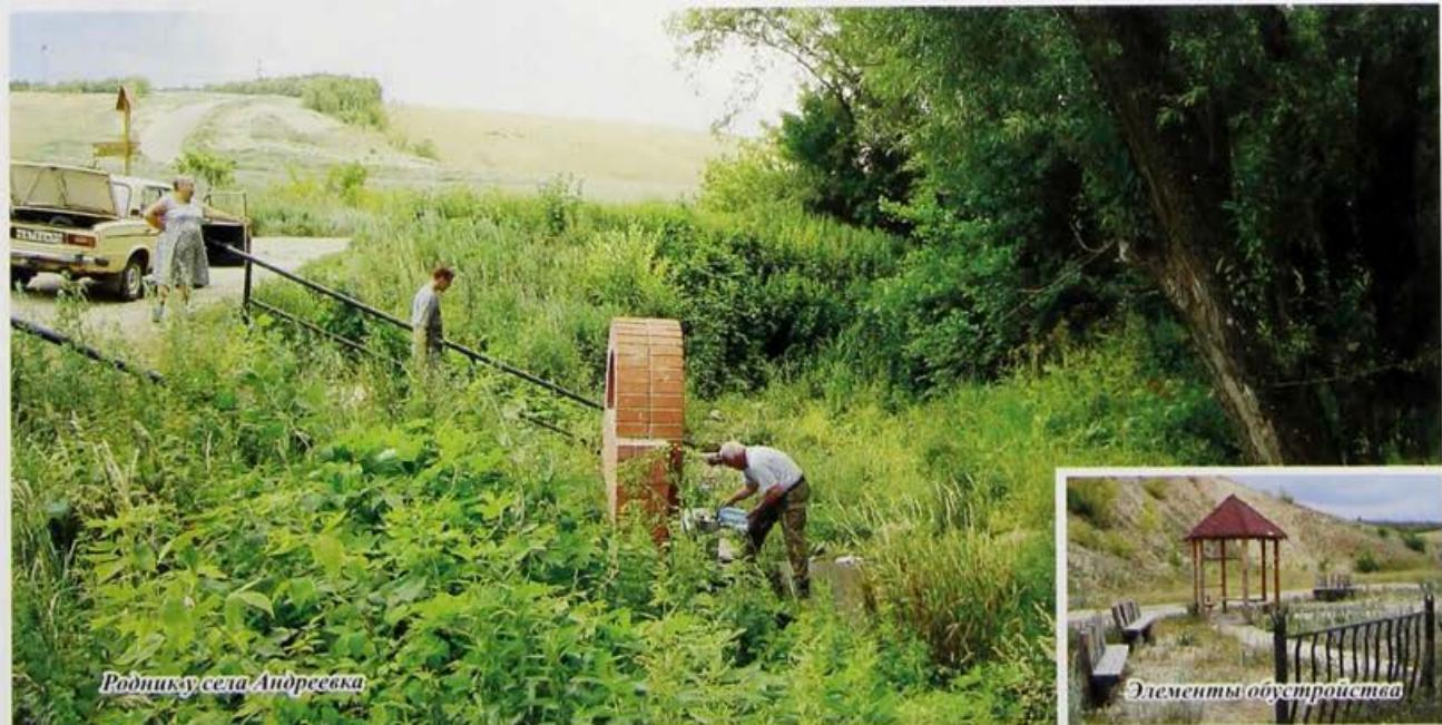
Источник расположен в 1 км от села Андреевка. Ключ нисходящего типа с дебитом 1,8 м<sup>3</sup>/час. Во время половодья родник не затапливается. Имеются обустроенный подъезд, зона отдыха, подходы к роднику. Зона санитарной охраны не создана из-за отсутствия водосборной стенки на каптаже, вода проходит мимо водоразборной трубы. При этом существенно ухудшаются санитарные условия отбора воды. Родник требует организации зоны санитарной охраны и дальнейшего обустройства.
