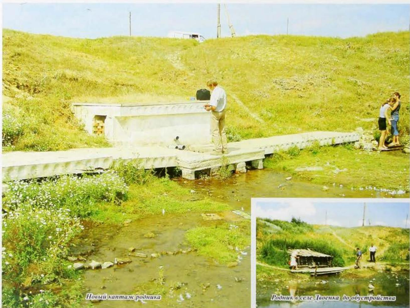
Строительство кантажной камеры произведено с грубыми нарушениями. В результате чего вода в водоразборные трубы не поступает.
