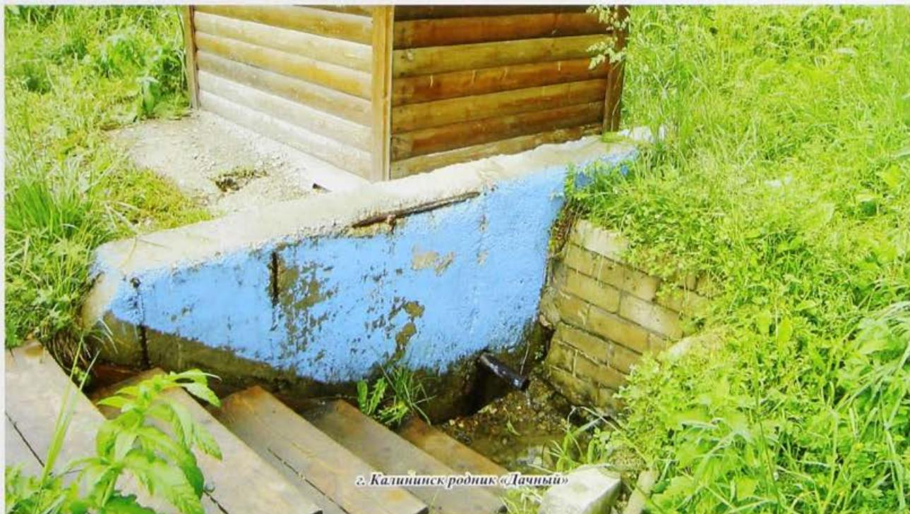
Родник расположен рядом с дачным массивом в 3 км на северо-запад от г. Калининска. Ключ нисходящего типа с дебитом 3,5 м<sup>3</sup>/час. Родник имеет бетонированный каптаж в виде крытого колодца с выводом водоотборного патрубка. Родник впадает в р. Баланду. Источник не имеет зоны санитарной охраны. Каптаж и территория вокруг родника требует благоустройства.
