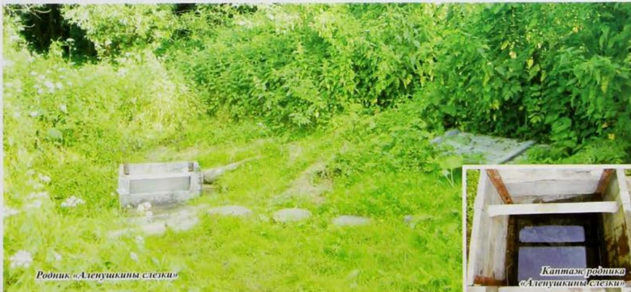
Родник расположен в 700 м восточнее села Трубетчино. Источник нисходящего типа с дебитом 0,2-0,3 м<sup>3</sup>/час. Каптаж выполнен в виде деревянного сруба. Вода из родника поступает в реку Хопер. До ближайшей жилой застройки 150 м. Источником пользуются до 60 человек в сутки. Зона санитарной охраны на роднике отсутствует. Территория вокруг источника заросла травой и кустарником.
