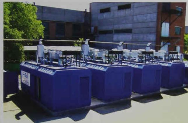
«Газовый двигатель-генератор ГДГ-90 в блок-контейнере мощностью 500 кВт (на фото представлено 4 агрегата суммарной мощностью 2 МВт)»
