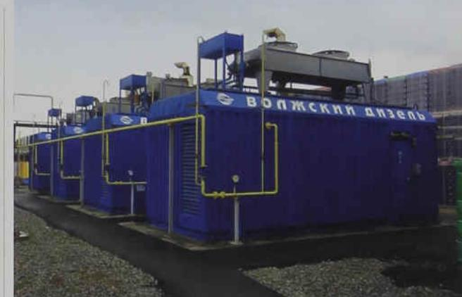
«Стекольный завод «Актис» (Ростовская обл., г. Новочеркаск). Энергокомплекс 2 МВт на базе 4-х газопоршневых двигателей-генераторов ГДГ-90 производства ЗАО «Волжский Дизель имени Маминых»
