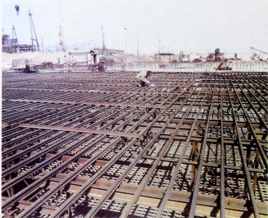
**Апрель 1981 года. Армирование фундаментной плиты машинного зала энергоблока № 1**
