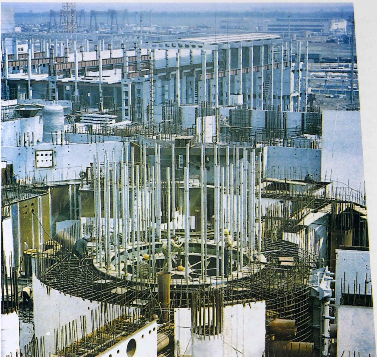
**Октябрь 1983 года. Монтаж шахты реактора первого энергоблока**
