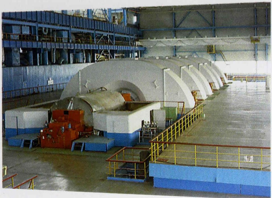
**В машинном зале энергоблока. Так выглядят турбина и генератор**
