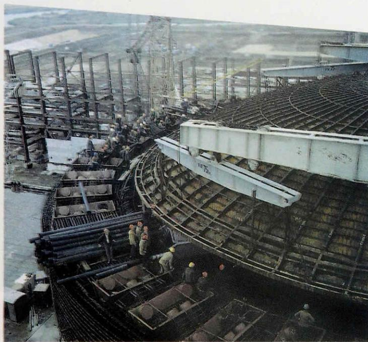
**Август 1984 года. Установка купола гермооболочки реакторного отделения № 1**
